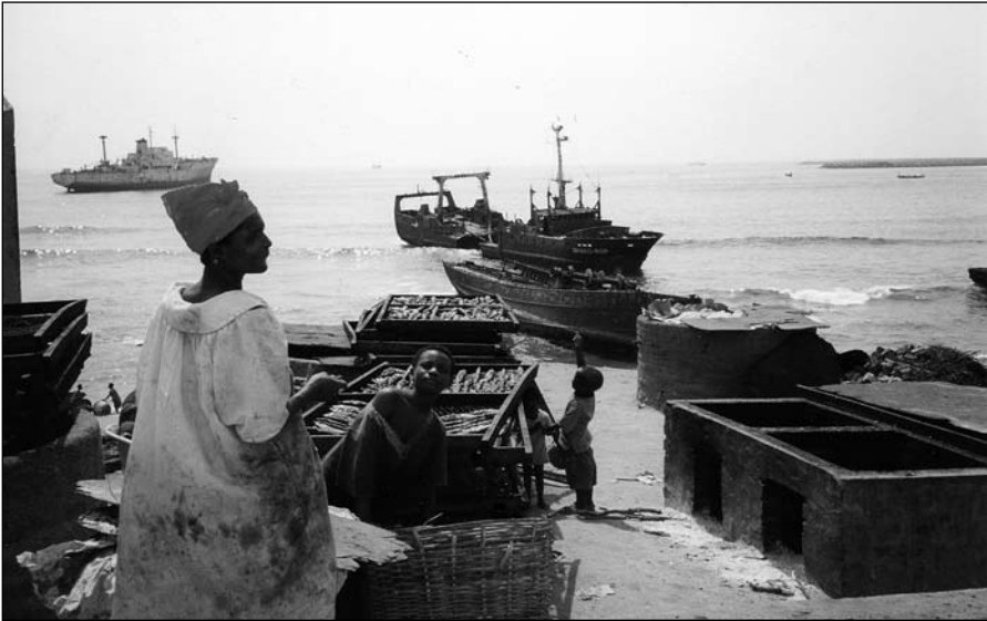
Für den Export von Kakao ließ Kwame Nkrumah den Überseehafen Tema bauen und daneben für Hafendarbeiter und Fischer Wohnsiedlungen mit Toiletten und Waschgelegenheiten, die noch heute vorbildlich sind.
